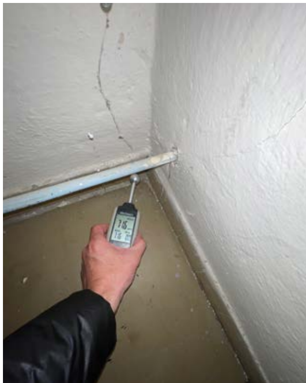
Spodní úroveň - Vlhkost 12%
