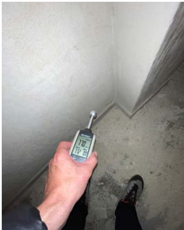
Spodní úroveň - Vlhkost 15%
