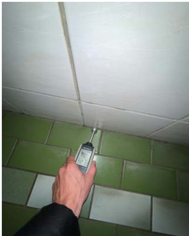
Spodní úroveň - Vlhkost 22%
