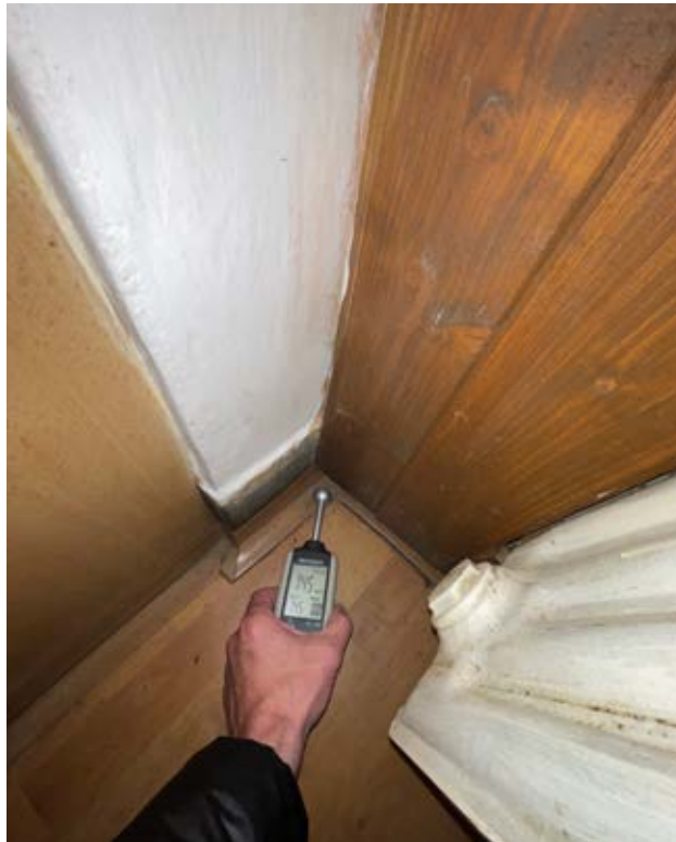
Spodní úroveň - Vlhkost 14%
