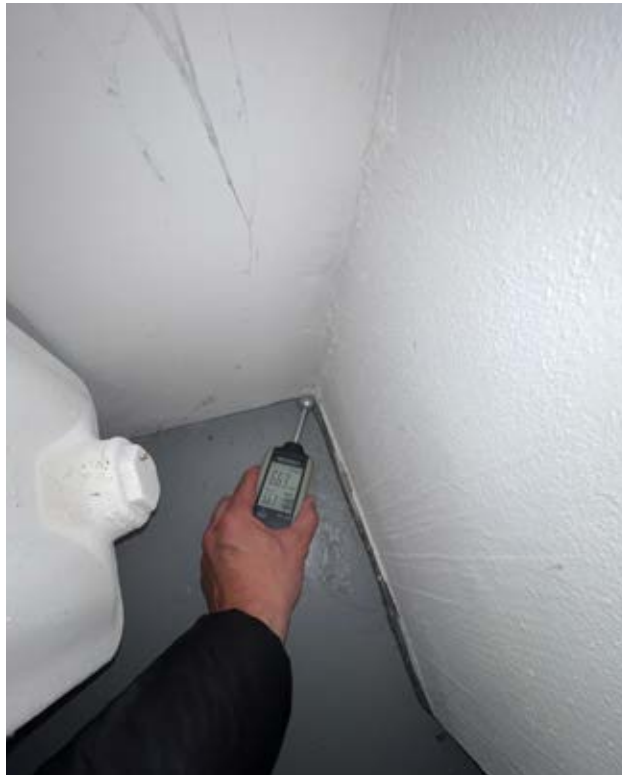
Spodní úroveň - Vlhkost 11%
