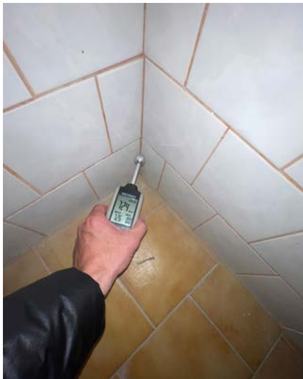
Spodní úroveň - Vlhkost 13%
